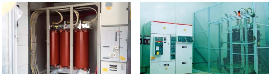
▶ Cabine di trasformazione MT/BT / MV / LV transformation cabins
